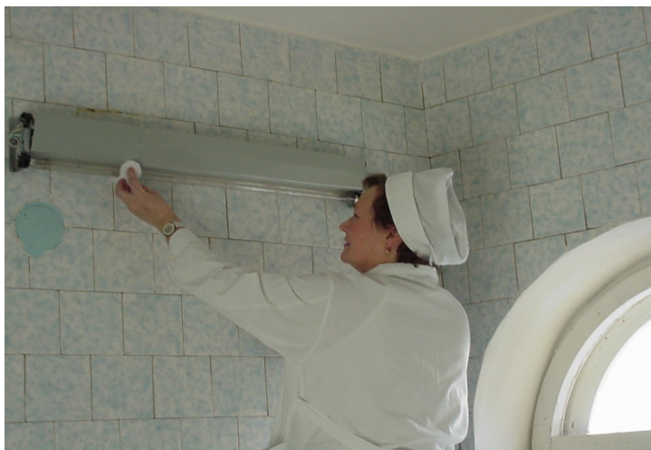
Рис. 6.9.4. Очистка поверхности УФ облучателя
