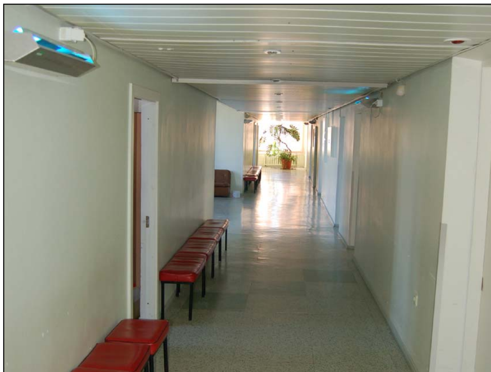
Рис. 6.9.3. УФ облучатели со щитом, предназначенные для непрерывного облучения верхнего воздушного пространства
